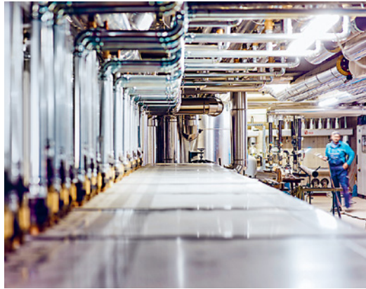
Energieeffizienzmaßnahmen werden um erneuerbare Energien ergänzt. Das Unternehmen Wipotec nutzt Erdwärme.
